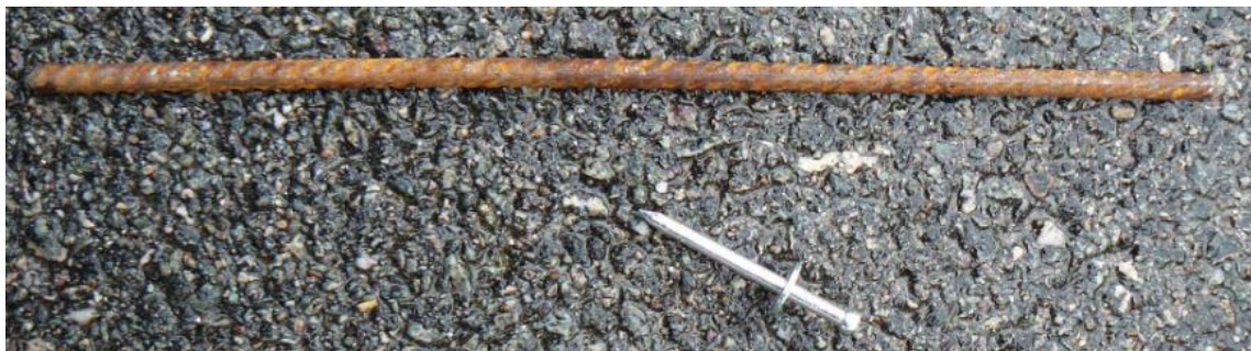
Obr. 4 Stabilizace bodu v exteriéru
