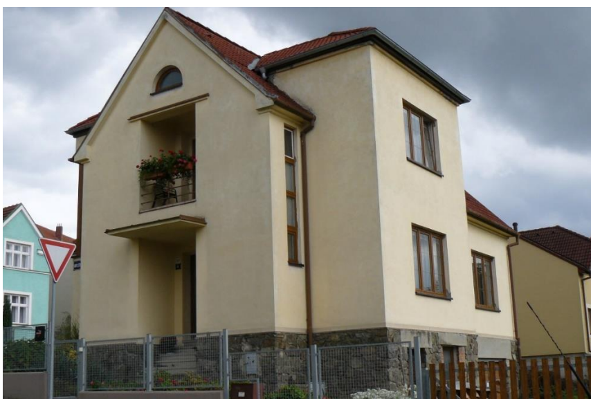
Obr. 1 Pohled na dům od severozápadu z ulice Havlíčkova
