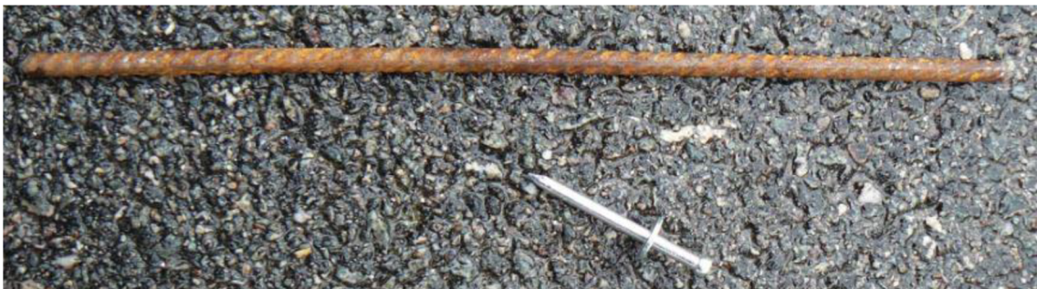
Obr. 4 Stabilizace bodu v exteriéru
