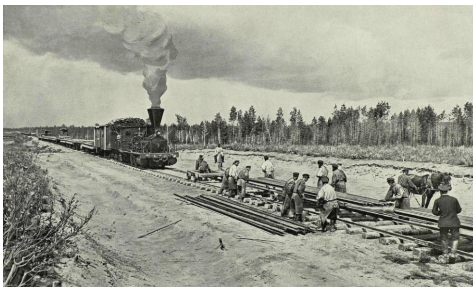
Příloha č. 3 - Pokládání kolejnic železnice
