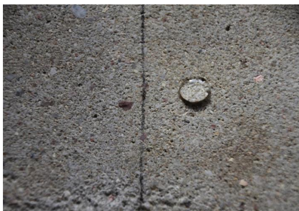
Obr. 4: 60 minut po navlhčení (kapka na hydrofobizované části stále perfektně drží svůj tvar)
