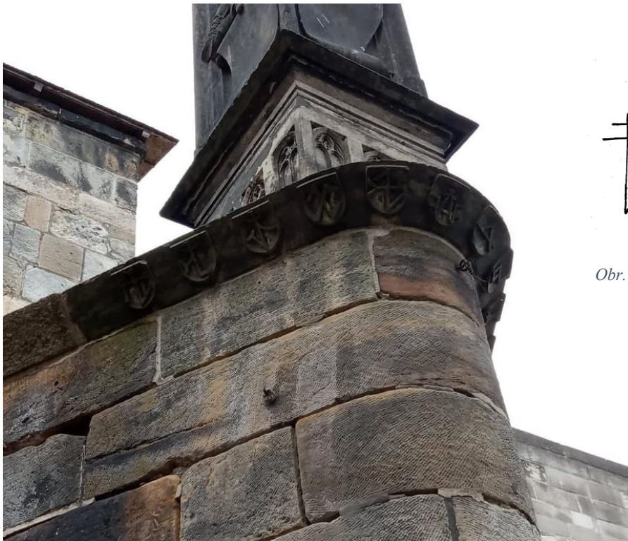
Obr. 9: Pilíř s erbovními kamenickými značkami řemeslníků pracujících na Karlově mostu
