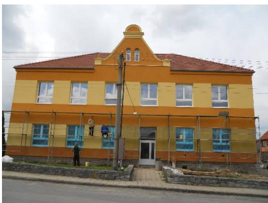
Obr. 9 - KD Východní pohled (květen 2016)
