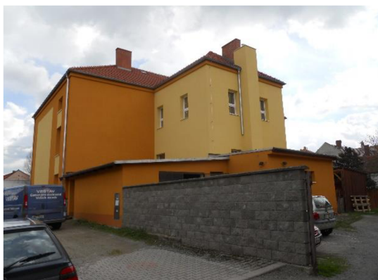
Obr. 11 - KD Severozápadní pohled (květen 2016)
