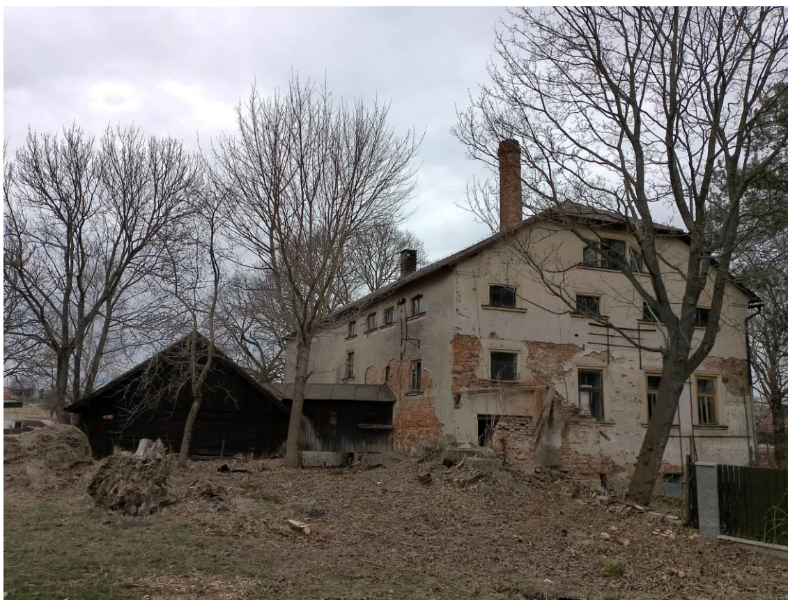
Obrázek 10 Objekt mlýnu a pily v Měříně č.p. 76 (Kotačková, 2023)
