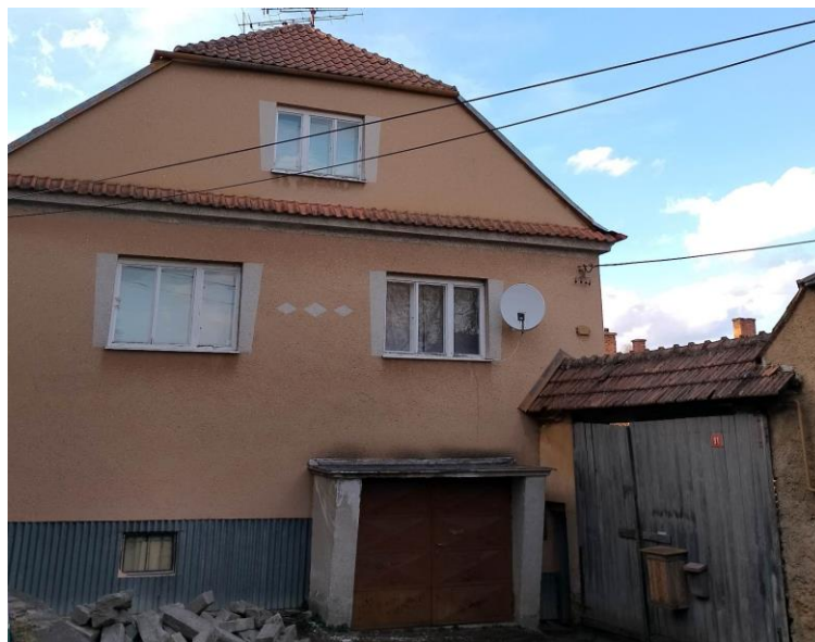
Obrázek 19 Bývalá vodohospodářská stavba v Křoví č.p. 44 (Kotačková, 2023)
