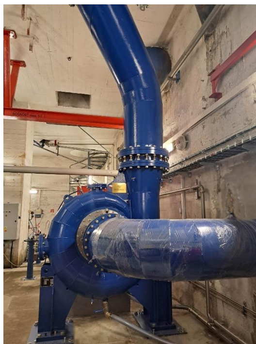
Obrázek 3 Vertikální uložení Francis turbíny (Kotačková, 2023)
