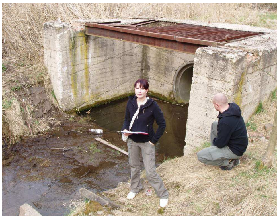
Obr. 5 Současný stav vtokového objektu zatrubnění
