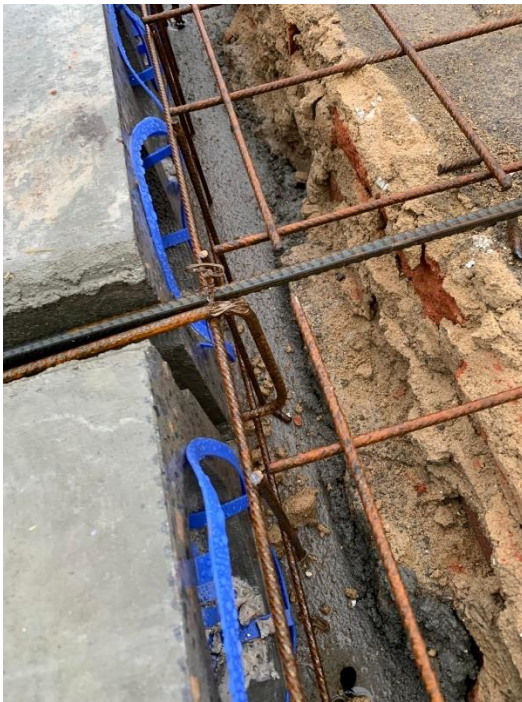
Obrázek 81- [foto autor] kotvení zálivkové výztuže
