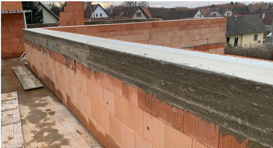
Obrázek 70- [foto autor] Pohled na odbedněný ŽB věnec z vnitřní strany
