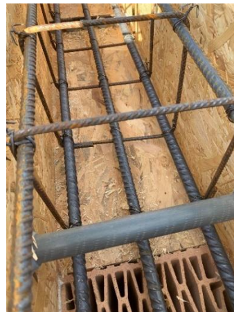
Obrázek 69- [foto autor] plastová zasouvacího kónusu pro ochranu betonářské spínací tyče
