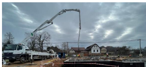
Obrázek 76- [foto autor] Autočerpadlo Schwing S43 SX III
