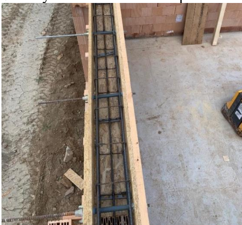
Obrázek 68 [foto autor] betonářské spínací tyče trubka včetně
