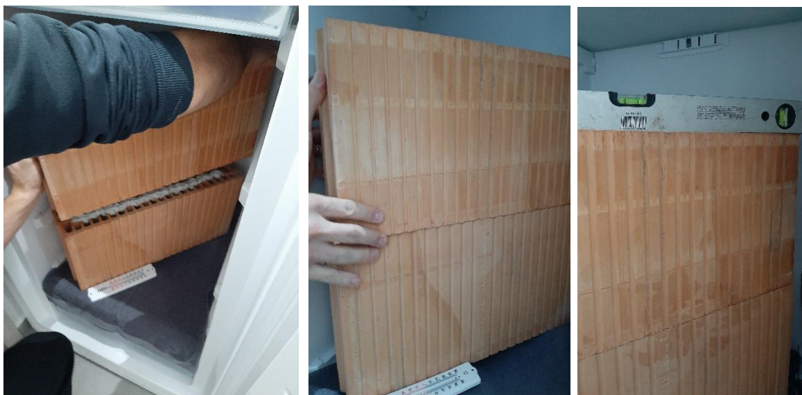
Obrázek 129 [foto autor] spojování zdících prvků VZOREK 2
