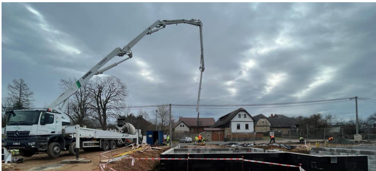
Obrázek 95 [foto autora] Autočerpadlo Schwing S43 SX III
