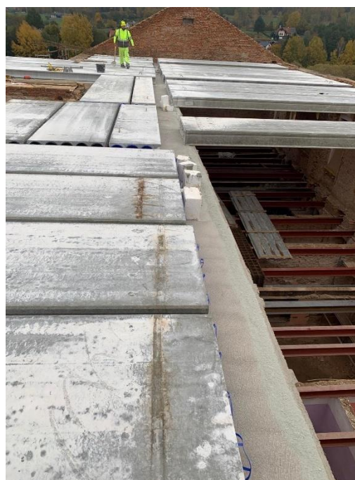
Obrázek 78- [foto autor] Ukládání stropních panelů na ŽB věnec
