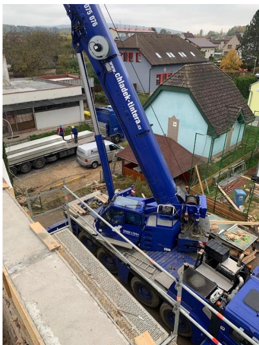
Obrázek 79- [foto autor] Montáž stropních dílců
