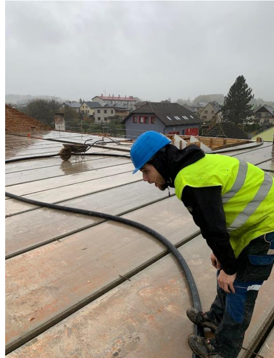
Obrázek 80 – [foto autor] betonáž spár
