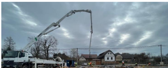
Obrázek 59- [foto autor] Autočerpadlo Schwing S43 SX III
