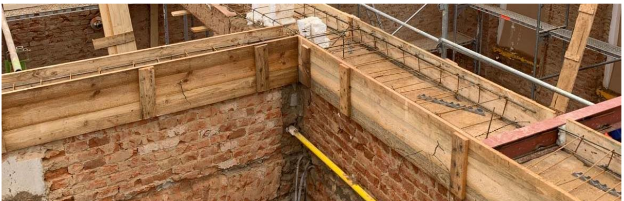
Obrázek 67- [foto autor] zhotovené dřevěné bednění na stavbě
