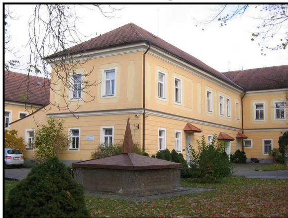
Obr.64 - SZ křídlo s kašnou - pohled z nádvoří
