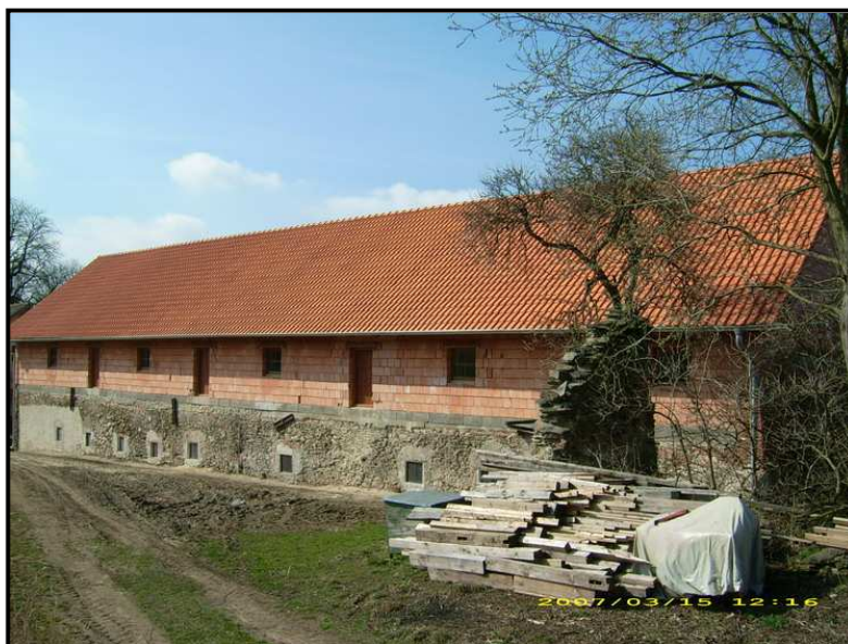
Obr.106 – objekt od východu - současný stav
