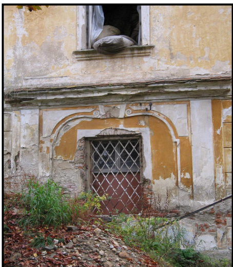
Obr.72 - portál vjezdu celkový pohled
