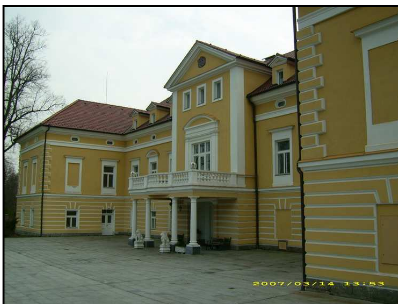
Obr.20 - pohled na vstupní průčelí s rizalitem
