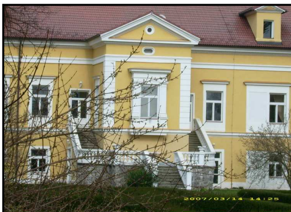
Obr.29 - rizalit se schodištěm
