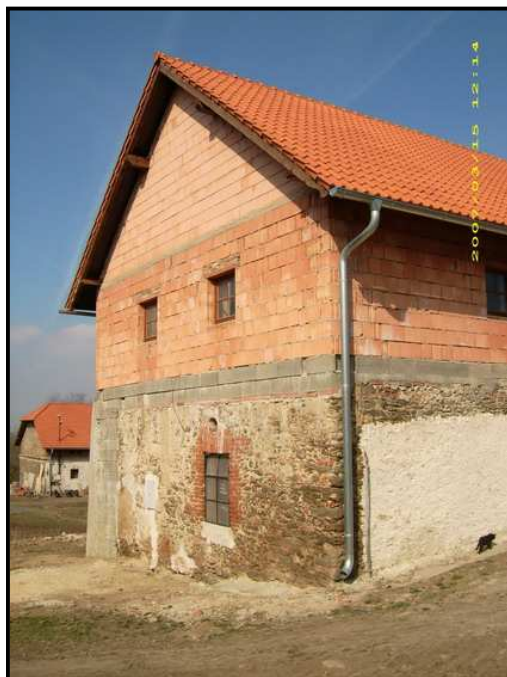
Obr.105 - JV průčelí – současný stav
