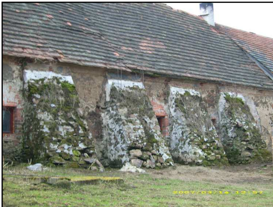
Obr.91 – opěráky na severní straně hosp. křídla
