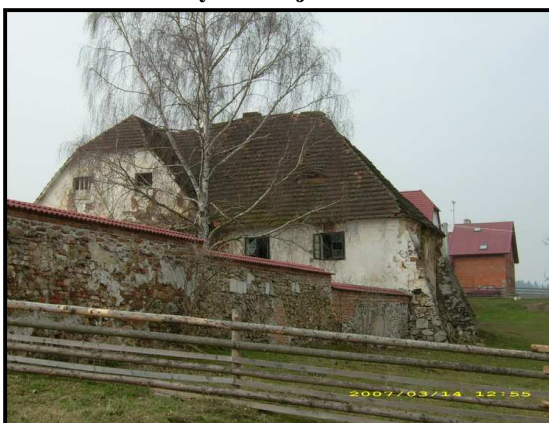
Obr.87 – současný stav objektu
