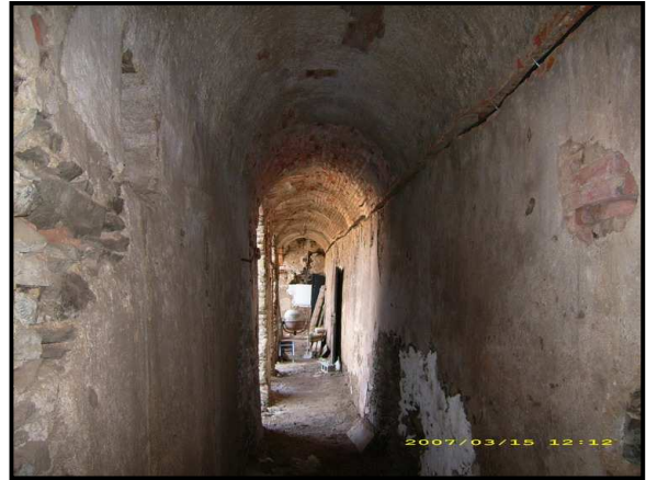
Obr.100 - arkádová chodba - interiér
