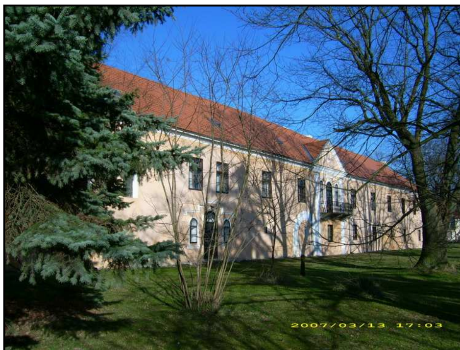
Obr.1 - pohled na průčelí jižního křídla
