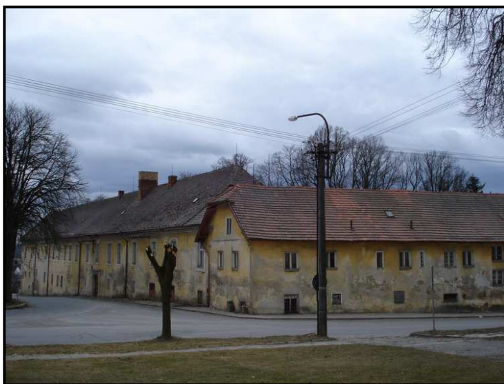
Obr.7 – pohled na zámek od jihovýchodu
