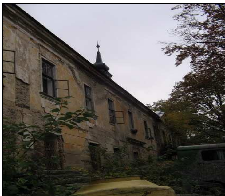
Obr.68 – západní křídlo - současný stav
