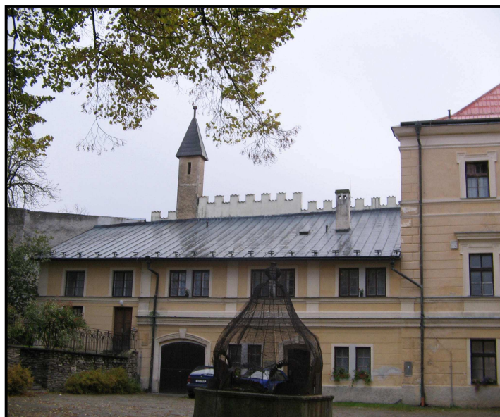
Obr.48 - prodlužování objekt s kašnou
