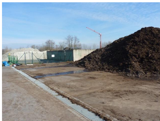
Obr. 25 Svod odpadní vody (autor 2015)
