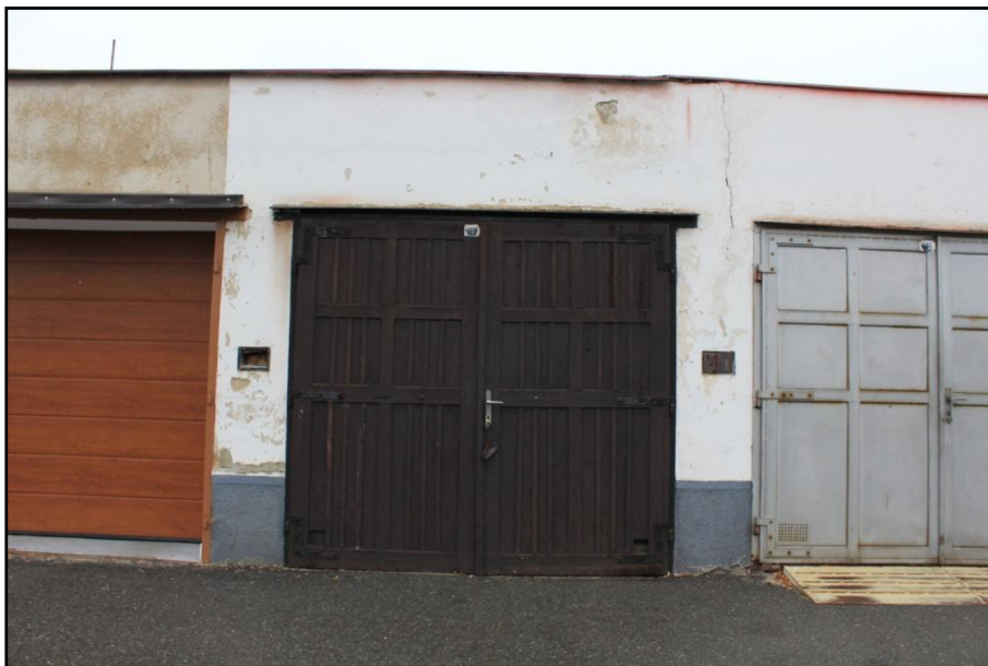
Obrázek 10: Garáž č. 2 UB (vlastní zdroj: fotografie)
