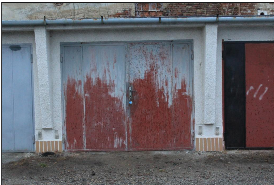
Obrázek 11: Garáž č. 3 UB (vlastní zdroj: fotografie)
