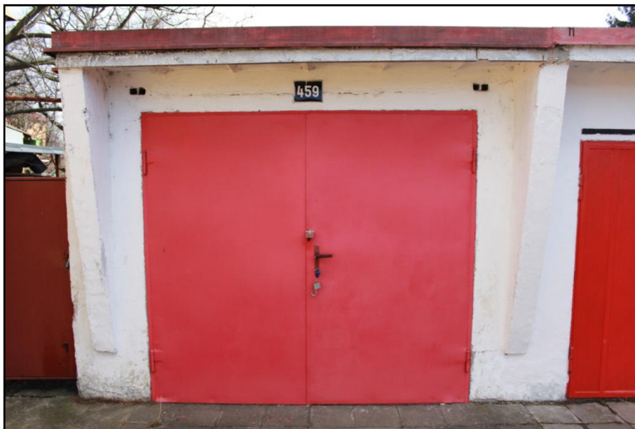
Obrázek 5: Garáž č. 3UH (vlastní zdroj: fotografie)
