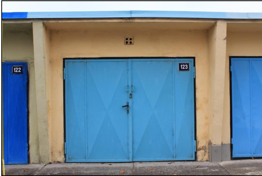
Obrázek 4: Garáž č. 2 UH (vlastní zdroj: fotografie)
