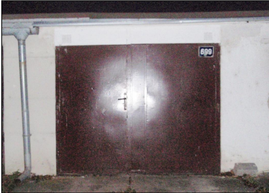
Obrázek 3: Garáž č. 1UH (vlastní zdroj: fotografie)
