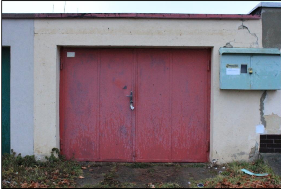
Obrázek 12: Garáž č. 4 UB (vlastní zdroj: fotografie)
