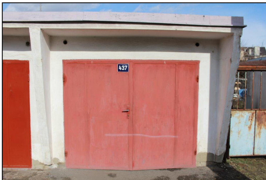
Obrázek 7: Garáž č. 5UH (vlastní zdroj: fotografie)
