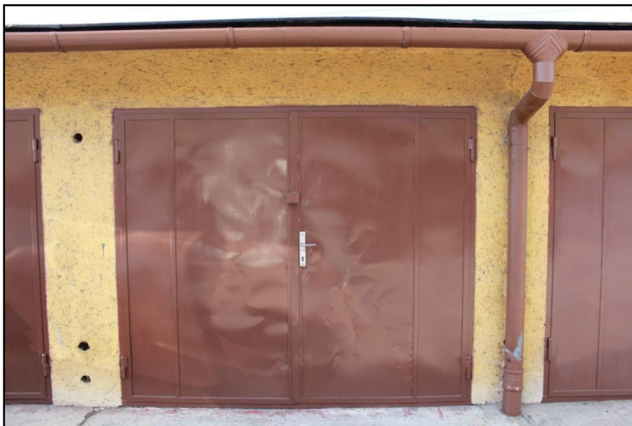
Obrázek 6: Garáž č. 4UH (vlastní zdroj: fotografie)
