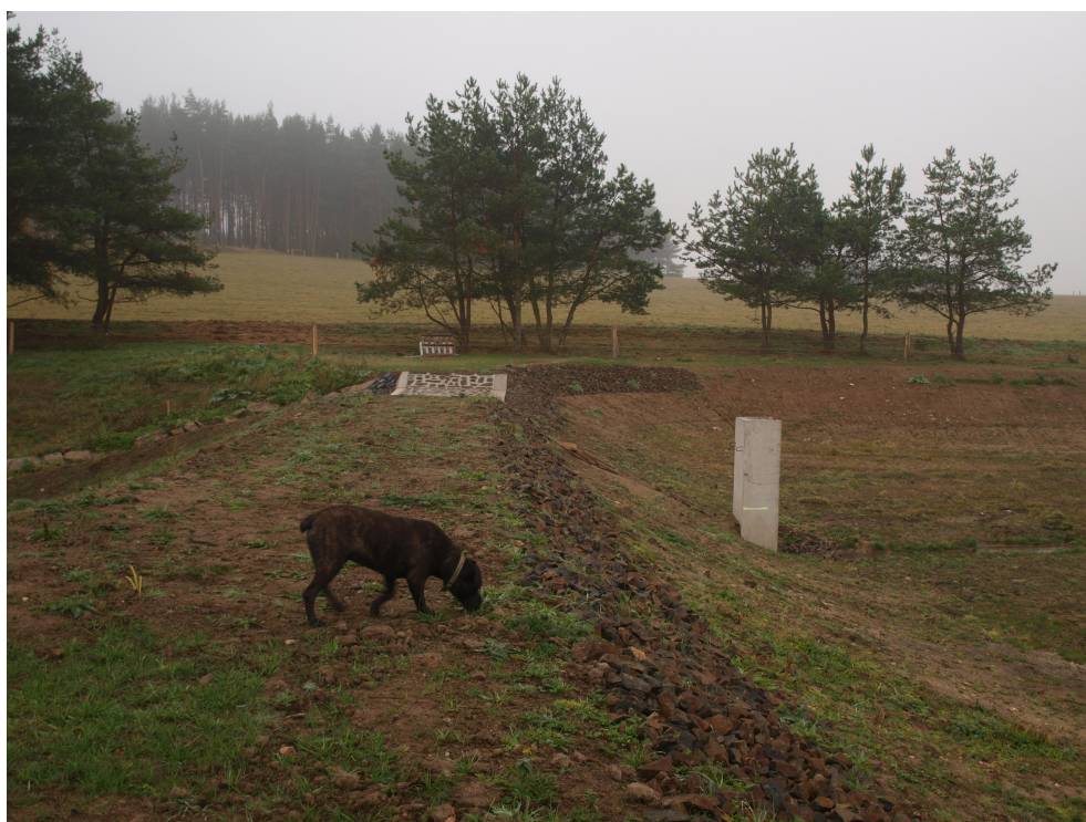
Obr. č. 6, Opevnění návodního líce hráze
