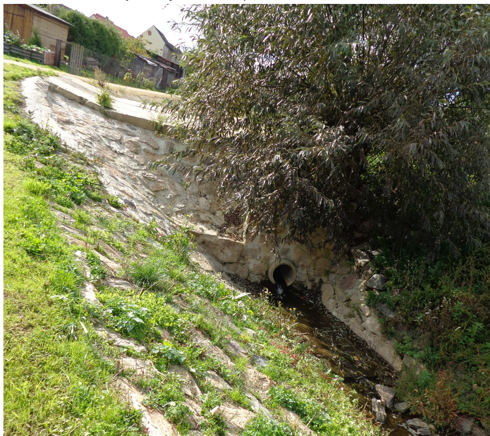
Obr. č. 8, Skluz a navazující koryto odtoku, ponechaná Vrba bílá
