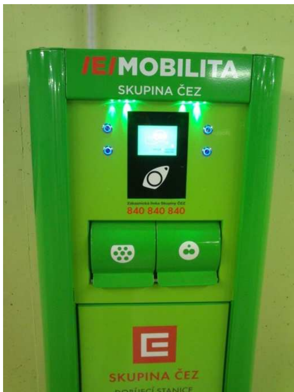
Obr. 10: Dobíjecí stanice 400V/32 A - 230V/16A v parkovacích garážích u Janáčkova divadla v Brně Zdroj: PAVEL ŠVÉDA
