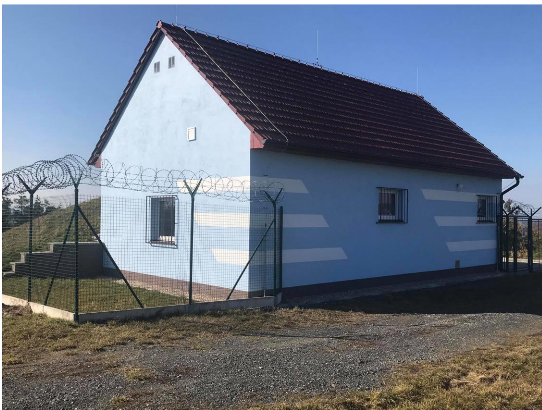
Obr. č. 9. Úpravna vody Vinice
