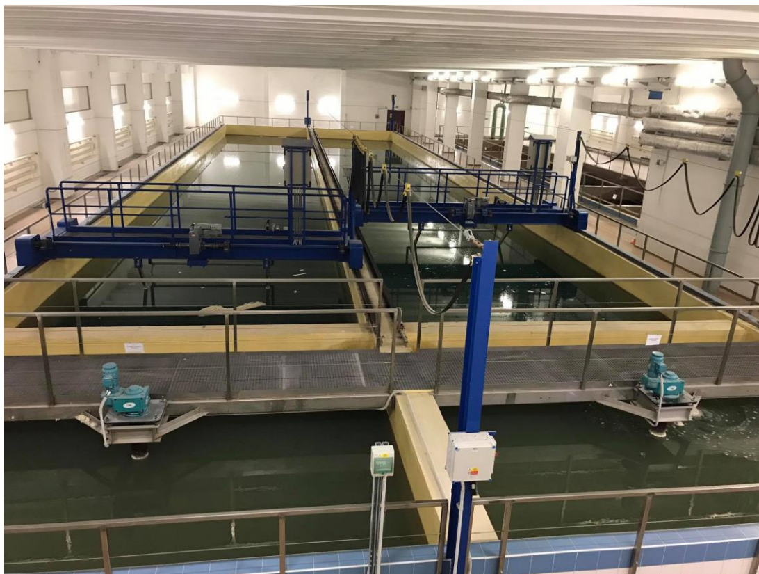
Obr. č. 8 usazovací nádrže v úpravně vody U svaté Trojice
