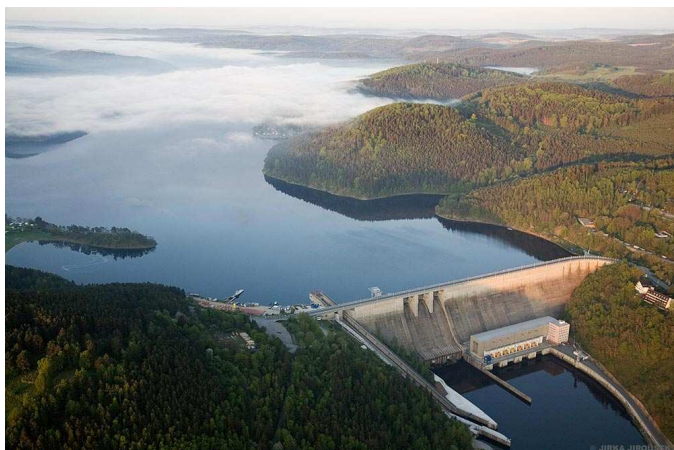
Obrázek 3 – Vodní elektrárna Orlík
