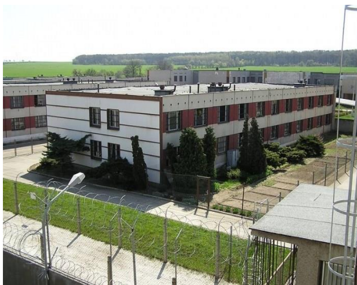
Obr. 5: Věznice Všehrdy (Vězeňská služba ČR, 2019g)
