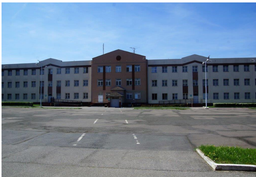
Obr. 8: Věznice Jiřice (Vězeňská služba ČR, 2019d)
