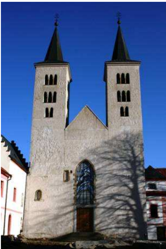
Obr. 5: Klášterní bazilika Navštívení Panny Marie (foto z http://kostelycz.cz/foto/57milevskon.jpg )
