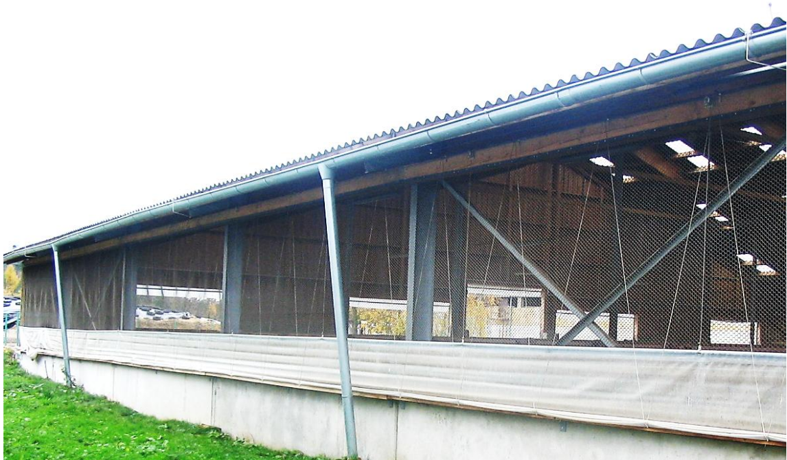
Obr. 4: Větrání bočními stěnami u stáje pro dojnice [19]
