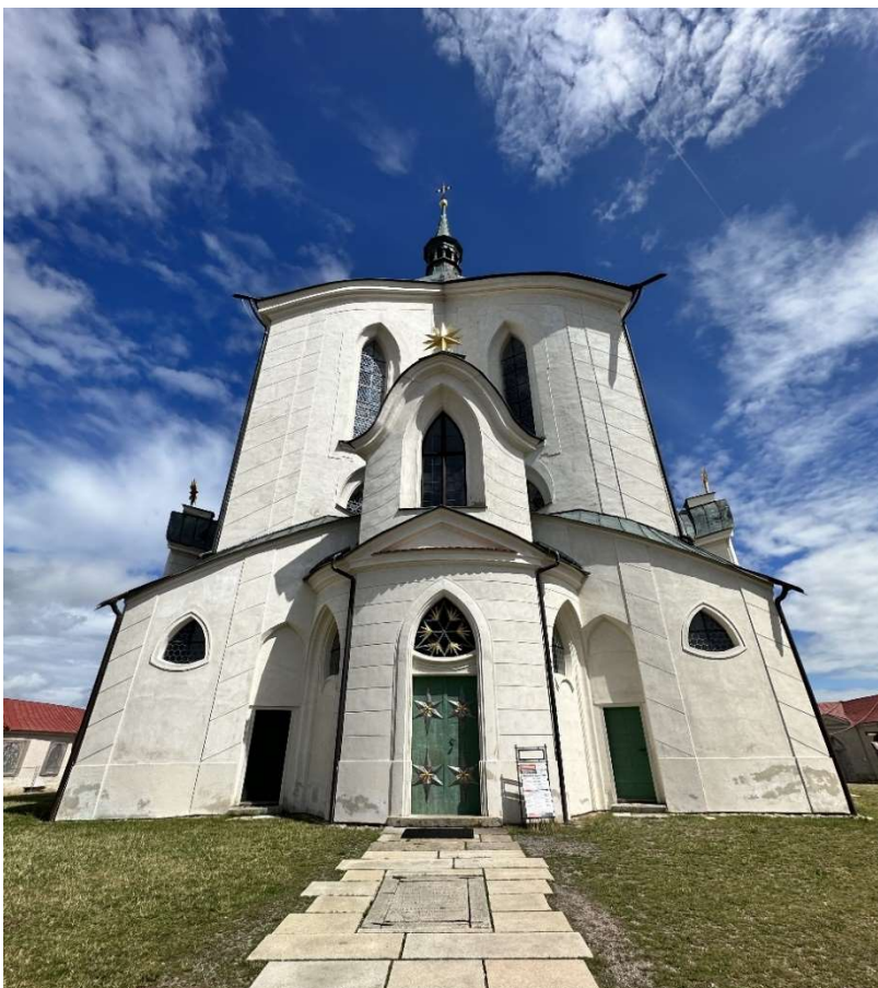
Obrázek č. 11 – Pohled na Poutní kostel sv. Jana Nepomuckého na Zelené hoře od hlavního vstupu do areálu
