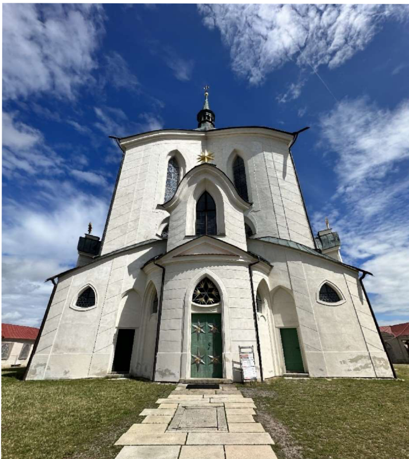
Obrázek č. 11 – Pohled na Poutní kostel sv. Jana Nepomuckého na Zelené hoře od hlavního vstupu do areálu
