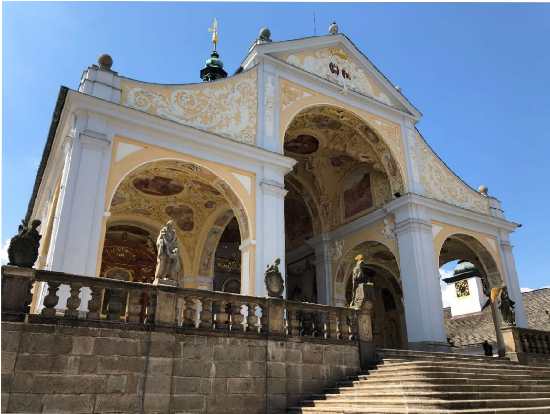
Obrázek č. 10 – Bazilika na Svaté Hoře u Příbrami – pohled z ambitů
