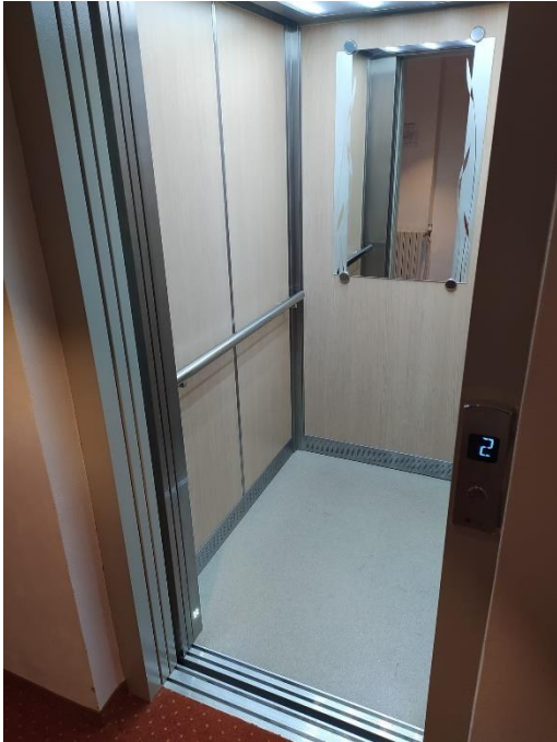
Obrázek 17 - Čistý, plně funkční výtah hotelu U Kata Zdroj: vlastní fotografie
