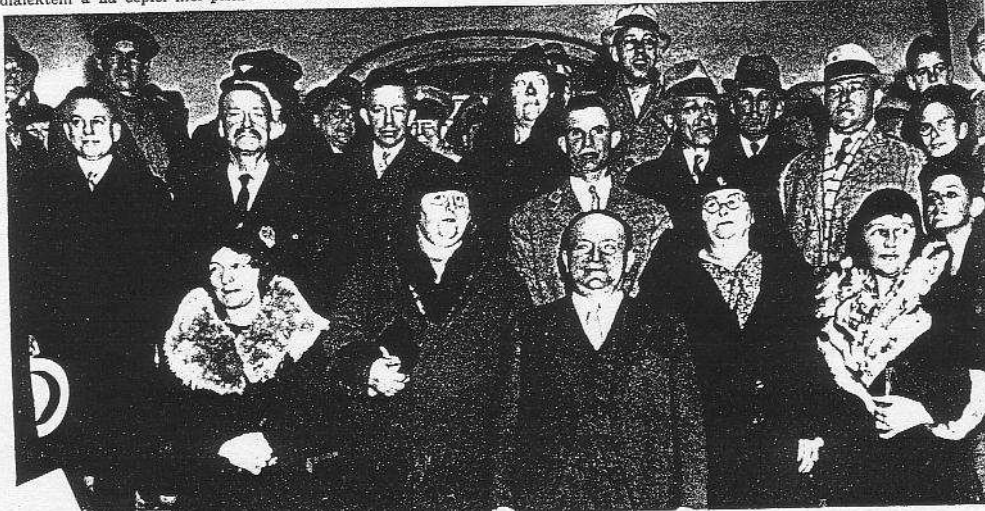
Porota, která Hauptmanna přes zoufalou námahu jeho obhájce uznala vinným a odsoudila jej na smrt.
