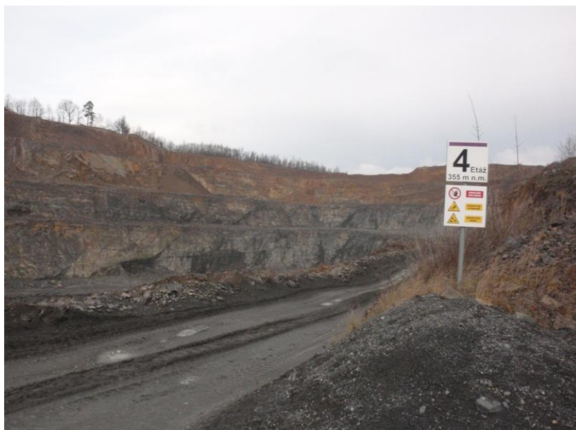
Obr. 13: Hrabůvka lom, stav v roce 2013.
