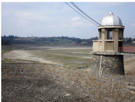
Obr. č. 5: Vypuštěná vodní nádrž Plumlov
