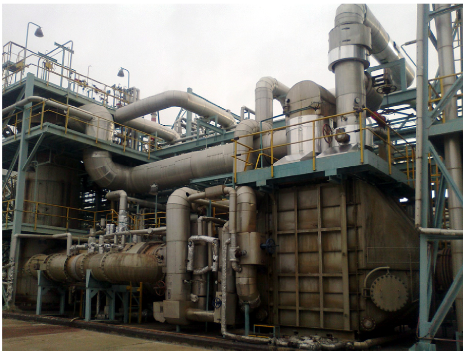
Obrázek 16: Přehřev odplynu ve zkoumané jednotce
