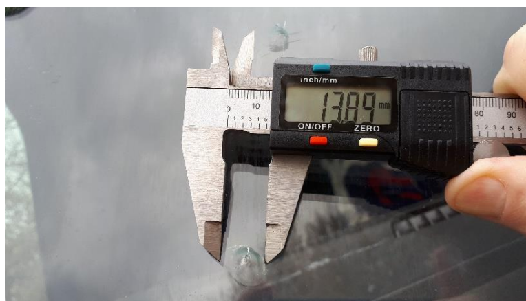
Obrázek č. 37 Poškození zasklení do 20 mm
