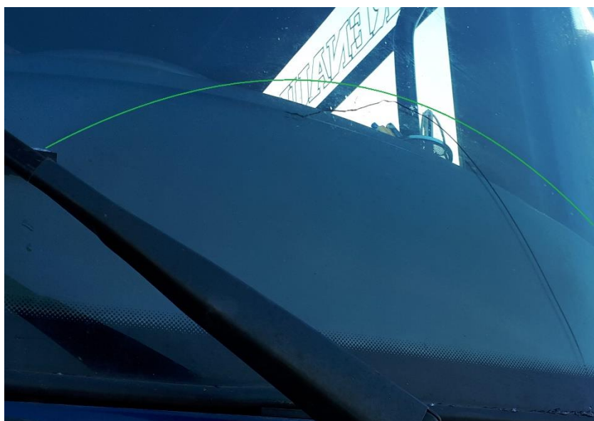
Obrázek č. 34 Prasklina mimo vymezenou část stírané plochy
