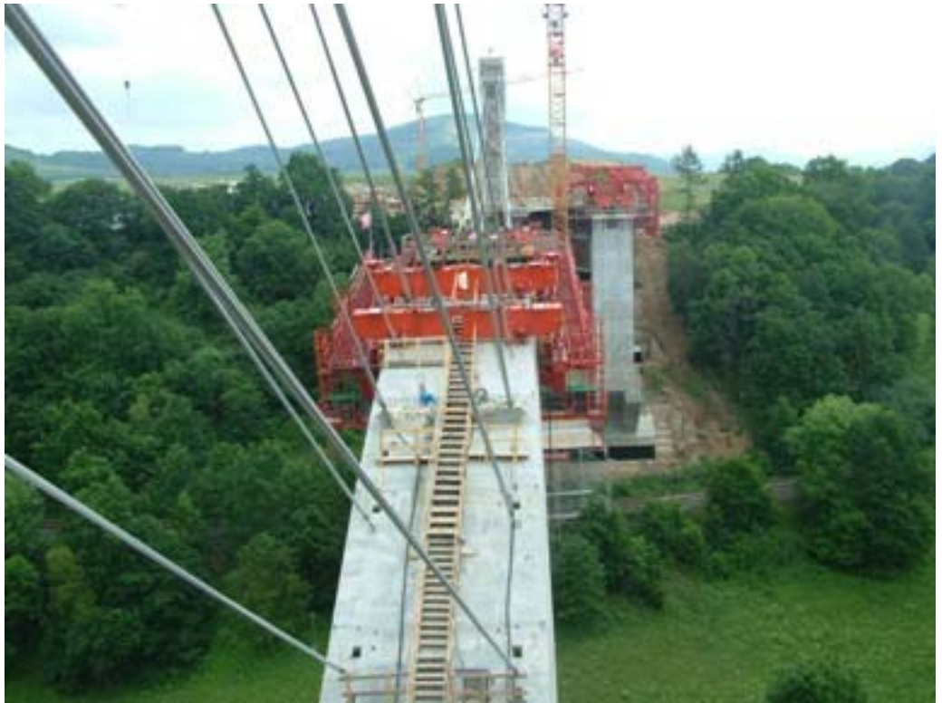
Obr. 11 – Stavba dálnice D8 přes Opárenské údolí
