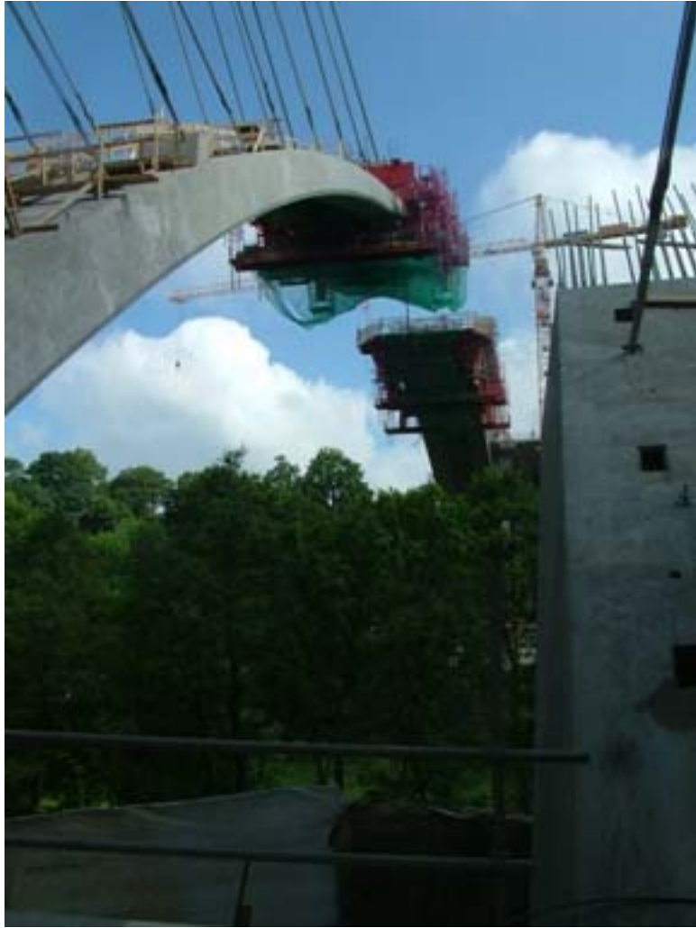
Obr. 12 – Stavba dálnice D8 v Opárenském údolí
