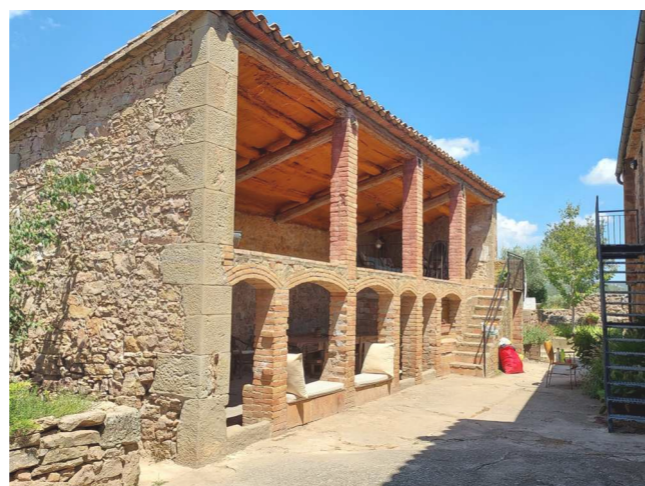
Obr. 68 Zastřešené místo pro posezení
