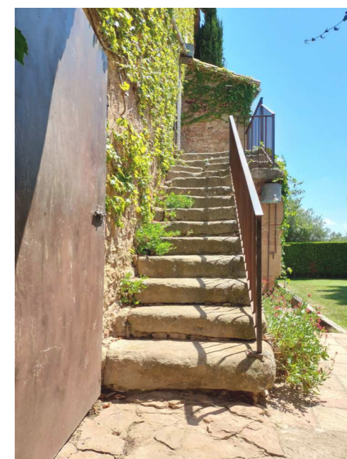
Obr. 75 Schody k balkonu v zahradě
