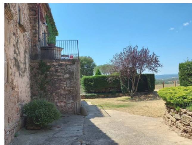
Obr. 69 Pohled ve vstupní části
