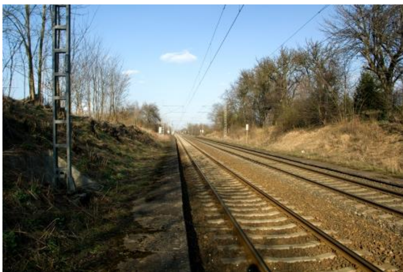
Obr. 14: Trať č. 140 procházející obcí Mikulovice
