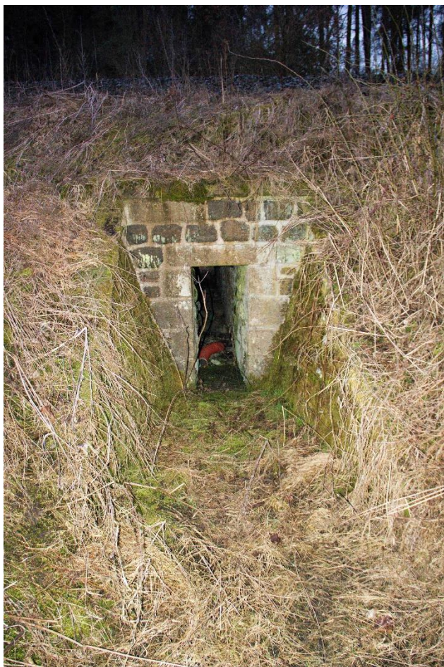
Obr. 23: detail tunelu na trati č. 140 pro přívod přítoku do potoka Bystřice
