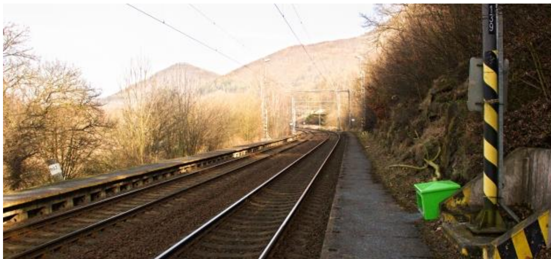
Obr. 16: Trať č. 140 procházející obcí Kotvina
