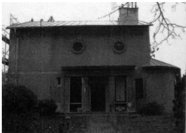
152/ Karel Kotas, Vila prokuristy Šopka v Bystřici pod Hostýnem, Poutní, 1938-1939, severní fasáda, současný stav. Foto: archiv autorky.
