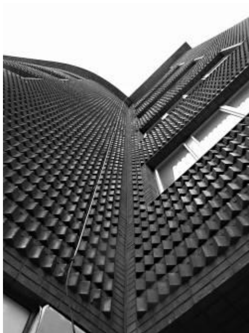
127/ Karel Kotas, Obchodní a nájemní dvojdům na Novém Městě pražském, v Sokolské ulici, detail keramického obkladu fasády, nedat. Foto: archiv autorky.
