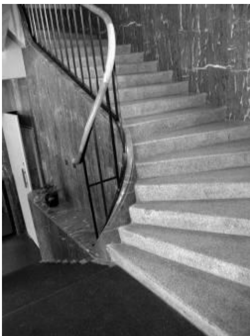
133/ Karel Kotas, Obchodní a kancelářský dům na Starém Městě pražském, v Perlové ulici, pohled do interiéru vstupní chodby, nedat. Foto: archiv autorky.
