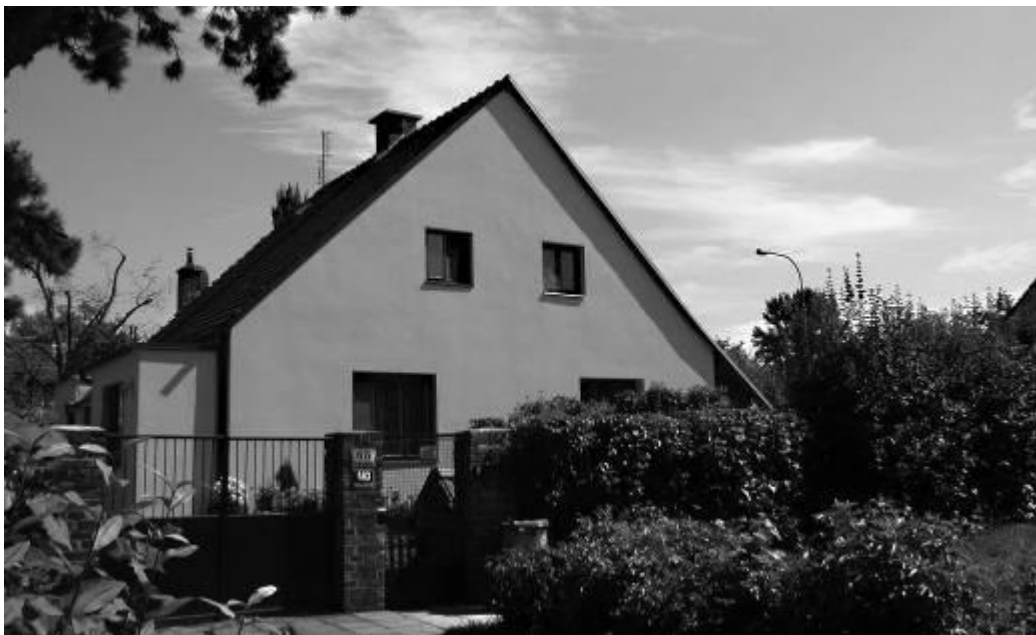
9/ Bohuslav Fuchs, Městská kolonie rodinných domků v Brně, v ulici Dolnopolní, uliční průčelí, současný stav. Foto: archiv autorky.
