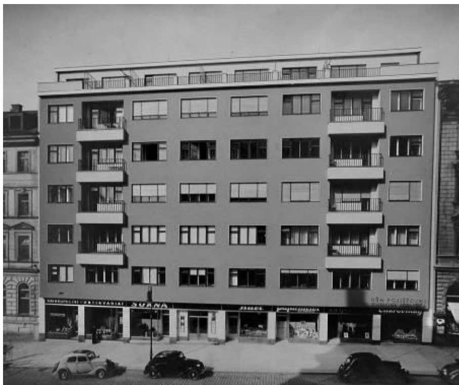
119/ Karel Kotas, Obchodní a nájemní dům na Novém Městě pražském, v Ječné ulici, dobová fotografie, celkový pohled, nedat. Reprofoto: NG Sbirka architektury Sbirky moderního a současného umění inv. č. AF 127.
