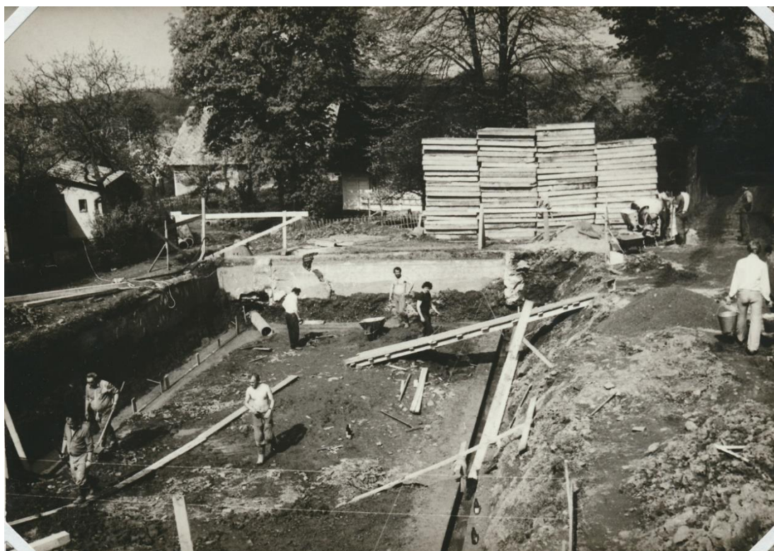
Foto č. 6: Stavba požární nádrže u č. p. 82 (SDH Borová 2016).
