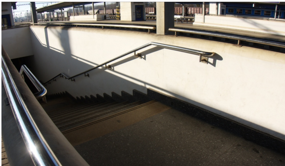
obr.č.37 schodiště vedoucí k nástupišti(autor)
