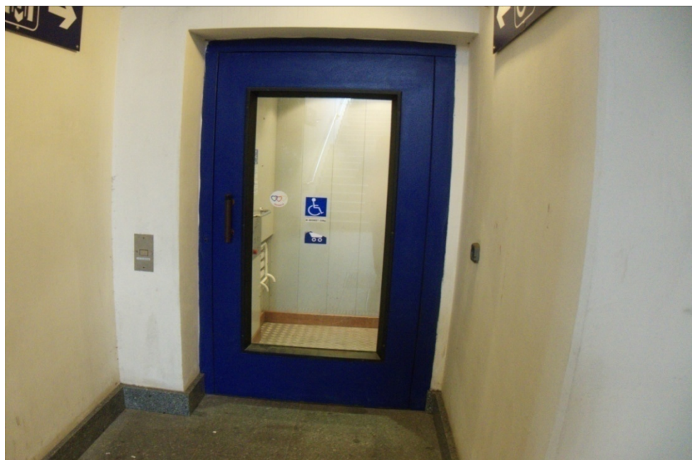
obr.č38 výtah v nádržní budově(autor)
