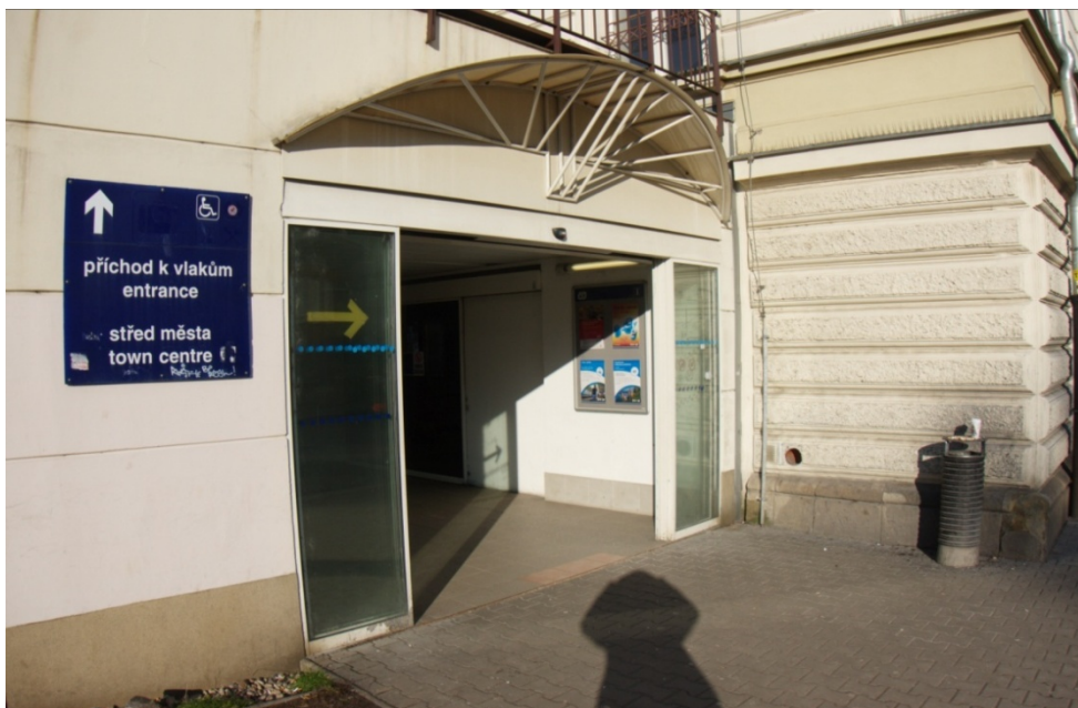
obr.č.36 vchod do nádražní budovy(autor)
