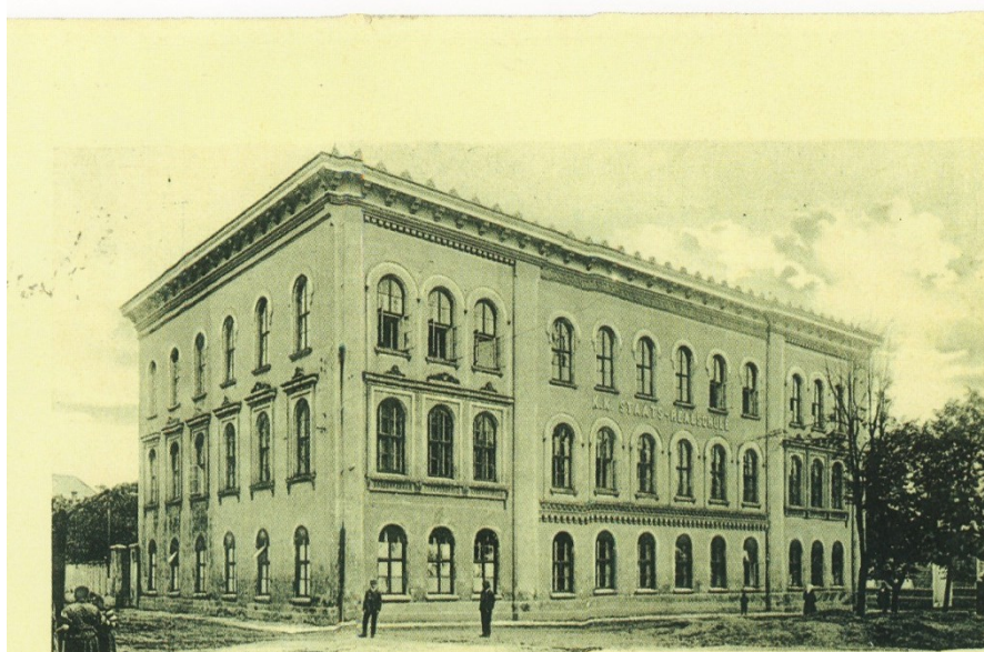
X. Budova v Komenského ulici postavená v roce 1872 pro německou obecnou a měšťanskou dívčí školu.
