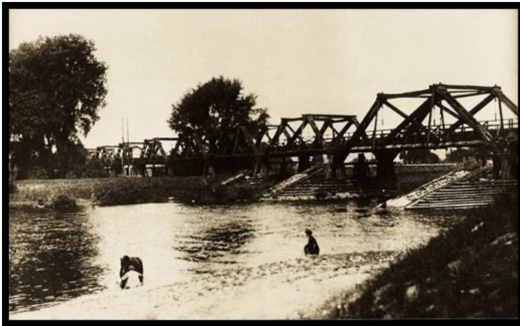
Obr.1.7. Dřevěný pilotový most mezi Holešovicemi a Libní. Sloužil až do roku 1928, kdy jej nahradil nový most Baxův (dnes Libeňský).
