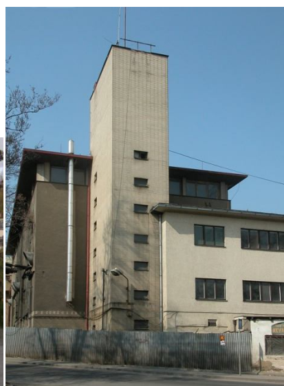
Obr.2.12. Budovy dílen a administrativy s vodojemem
