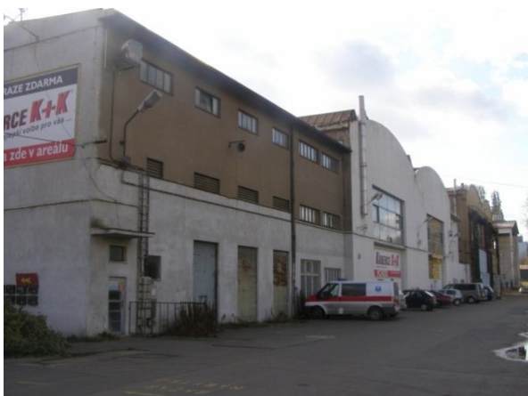
Obr.2.7. Bývalé opravárenské haly
