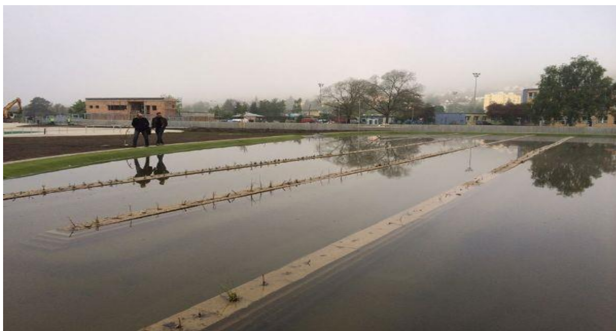
Obrázek č. 15 Rozestavěný biotop v Radotíně, čisticí část – filtrace. Zdroj: Oficiální stránky Městské části Praha 16.
