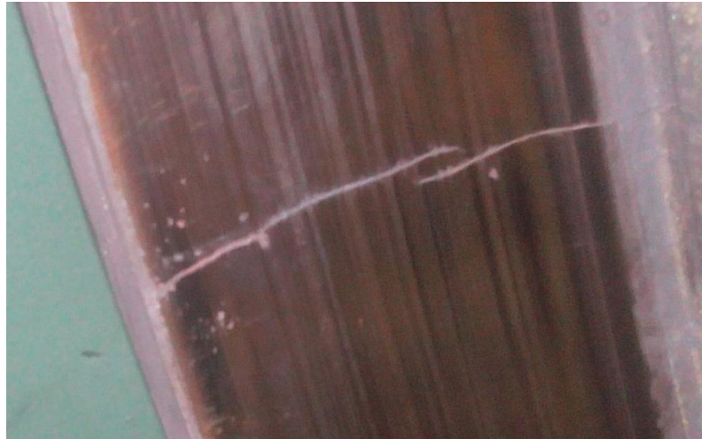
Obr. 13 Detail trhliny klínové řemenice
