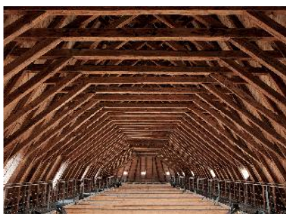
113. Praha – Staré Město, bývalý kostel sv. Anny, krov. Foto: Ústav dějin umění AV ČR, Praha – Petr Zinke
