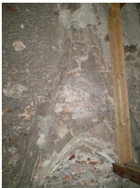
84. Olomouc, kostel sv. Kateřiny, jihozápadní průčelí kostela patrné v půdním prostoru přilehlých budov, pozůstatek portálu vstupu na emporu. Foto: Klára Mezihoráková
