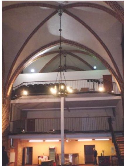
36. Vratislav, bývalý kostel sv. Kateřiny kláštera dominikánek, interiér rekonstruované lodi, pohled k západu. Foto: Klára Mezihoráková
