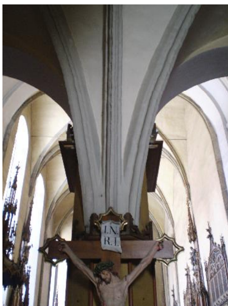
81. Olomouc, kostel sv. Kateřiny, interiér, detail výběhu klenebních žebér empory. Foto: Klára Mezihoráková
