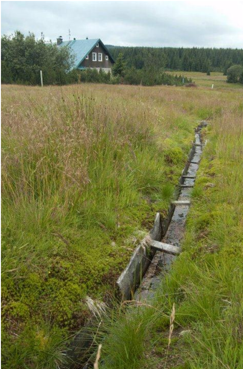
Obr. 9: Obnovený přívod vody k domu čp. 38
