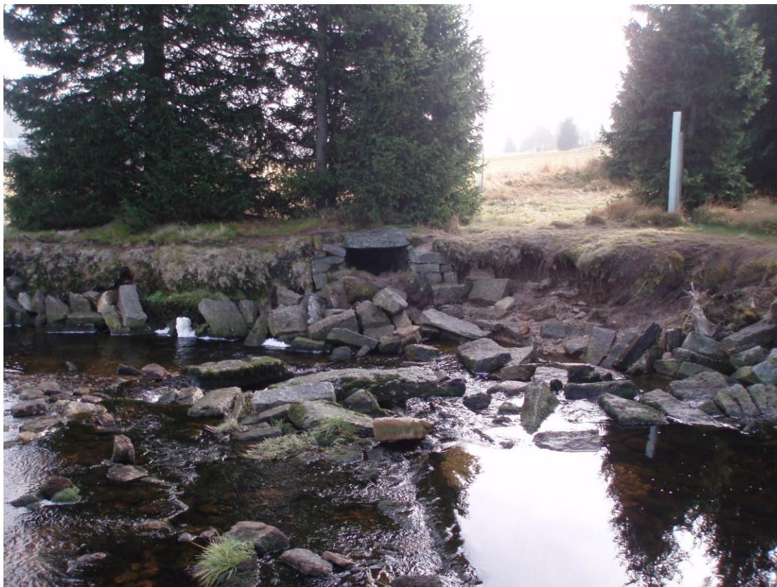
Obr. 12: Přívod vody k Nové sklárně
