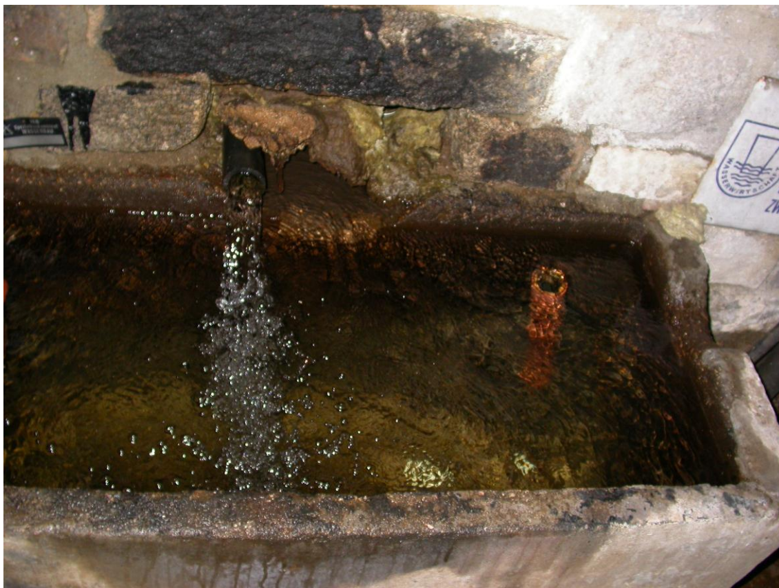
Obr. 7: Přívod vody do domu čp. 8
