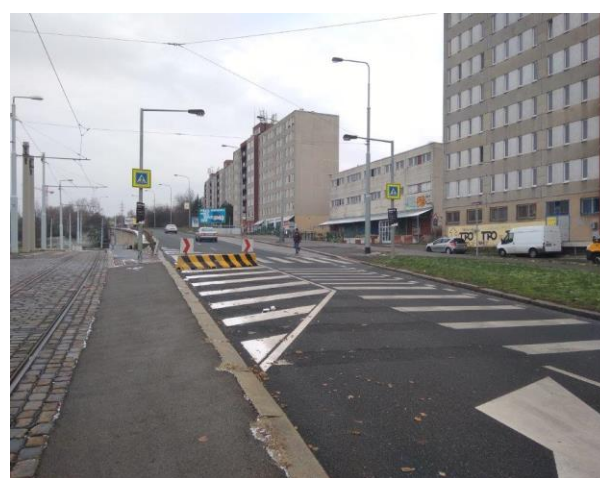
Obr. č. 37: Lehovecký přechod po úpravě (II)
