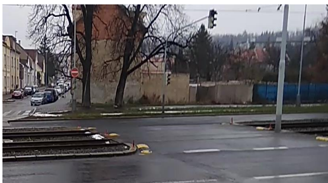
Obr. č. 18: Montované prahy v křižovatce (zdroj: autor 2018)
