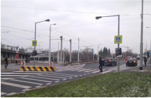
Obr. č. 38: Lehovecký přechod po úpravě (III) (zdroj: autor 2018)
