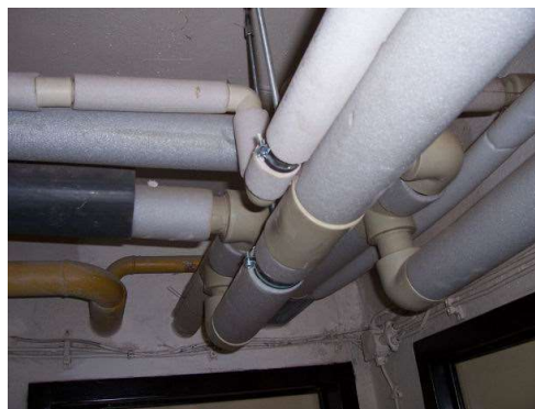
Obrázek 34 Rozvody v suterénu
