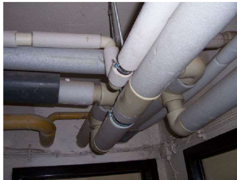
Obrázek 34 Rozvody v suterénu
