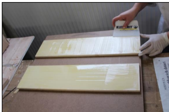
Obr. 23 Nanášení jednosložkového PUR lepidla stěrkou
