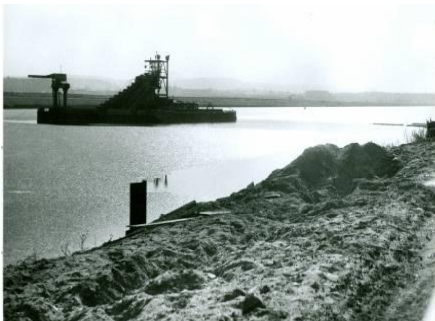
foto č. 2 Těžební bagr „Orlik“ na kanále při práci (Spartak, 1985):
