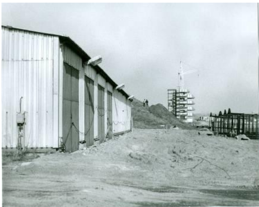
foto č. 3 Dostavba hlavní startovací věže a šaten (Spartak, 1985):
