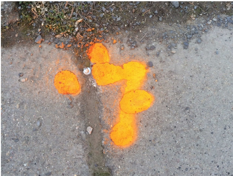
Obrázek 4 Stabilizácia nových bodov bodového poľa
