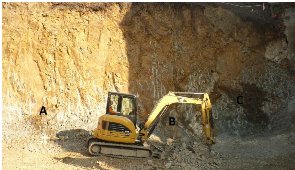
Obr. 2-3 Skalní stěna zbavená dřevin, náletů a vyčnívající horniny [Foto T. Bíba]
