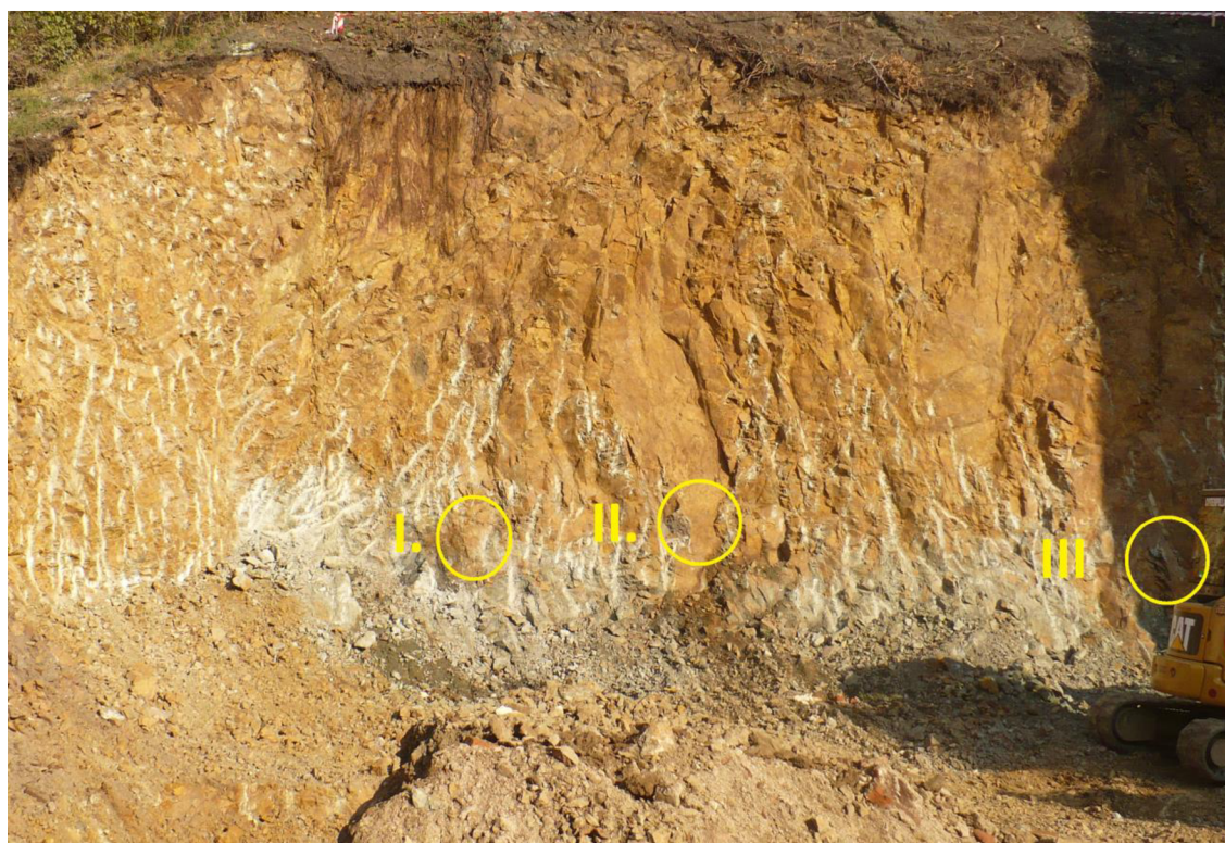
Obr. 2-8 Rozmístění zkušebních míst na skalní stěně [Foto T. Bíba]
