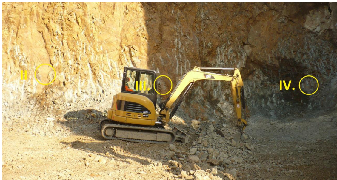
Obr. 2-9 Rozmístění zkušebních míst na skalní stěně [Foto T. Bíba]
