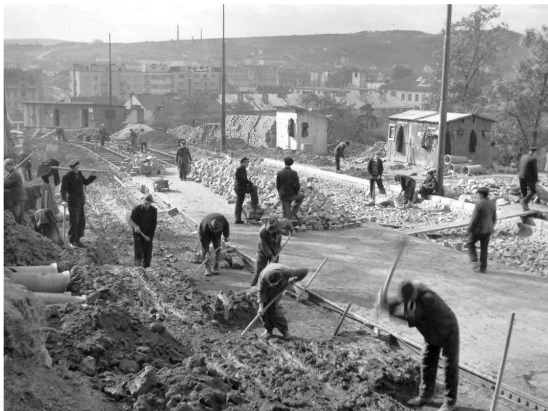
Obr. 1-5 Historické foto:1941 Stavba tramvajového propojení s Nádražní ulicí pod Petrovem [7]
