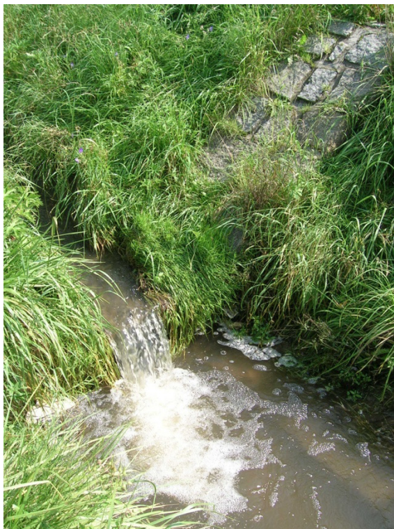
Obr. 7. 5 – Spádový stupeň na Rakovci ř. km 0,096
