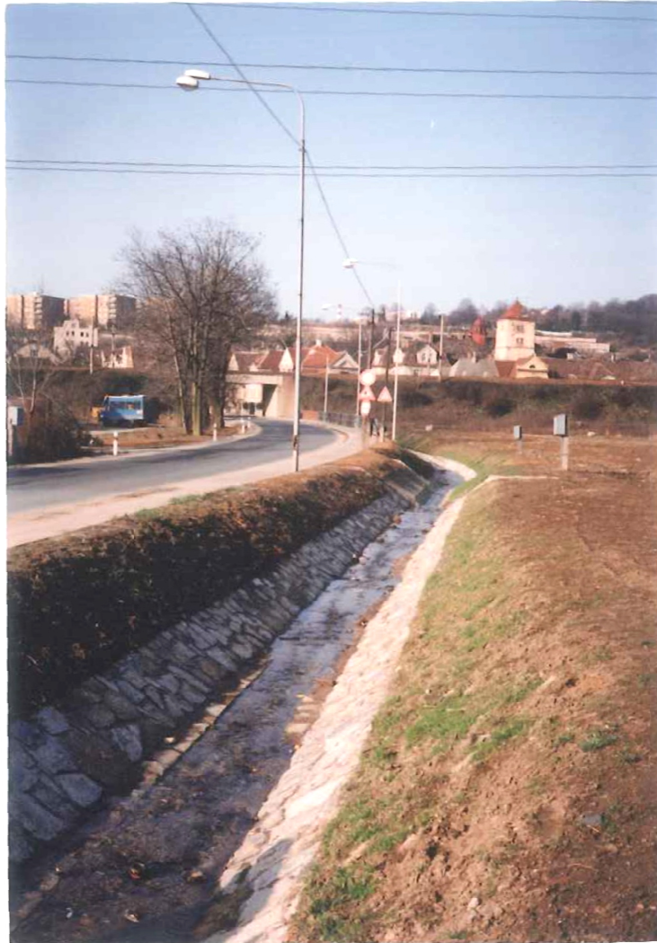
Obr. 4. 2 – Koryto potoka Rakovce ihned po realizaci úpravy v roce 1994 [23]
