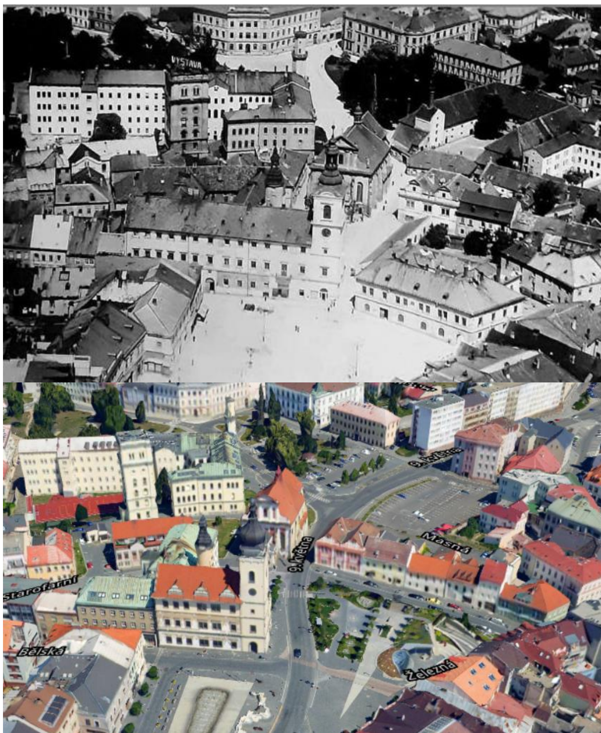
Obrázek 5: Severní část Staroměstského náměstí. Budova hejtmanství a areál pivovaru bránily snadnému průjezdu dostavníků, povozů a později nákladním automobilům a autobusům. Z toho důvodu vedla silnice I. třídy Železnou ulicí. To se změnilo po náletu na město v roce 1945 a zbourání pivovaru v sedmdesátých letech, od kdy silnice vede ulicí 9.května.
