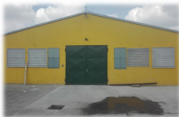
Obrázek 8 – Pohled na stěnu s ventilátory, Zdroj: Autor
